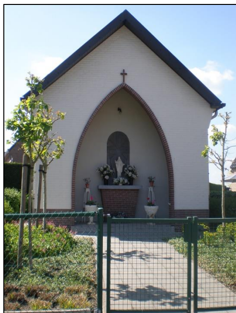
Afb. 4 - De nieuwe H.Hartkapel verwerkt in een elektriciteitskabine
