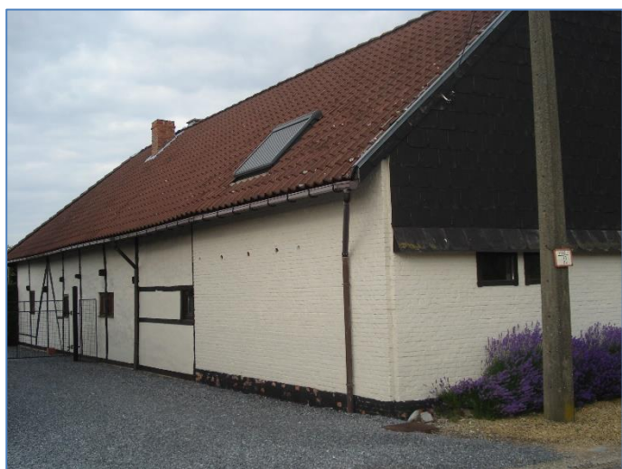
Oude zijgevel, buiten, linkerzijde
