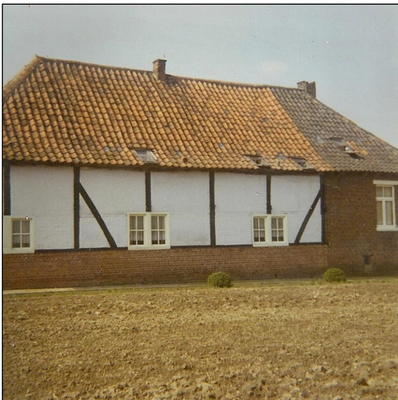
Lemen vakwerkhuis Grammen (voor 1747) in de Opperstraat te Wijer. Foto uit 1970, toestand voor de huidige ingrijpende verbouwing. Het rechtse deel in baksteen werd in 1891 aangebouwd n.a.v. de eremis van pater Marcellinus.
