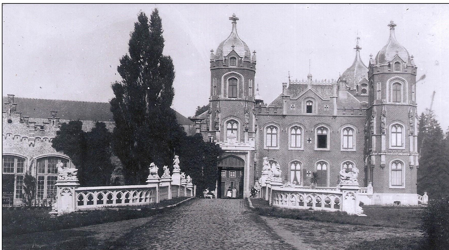
Kasteel in Neotudorstijl gezien vanaf de zuidelijke inrit na 1862
