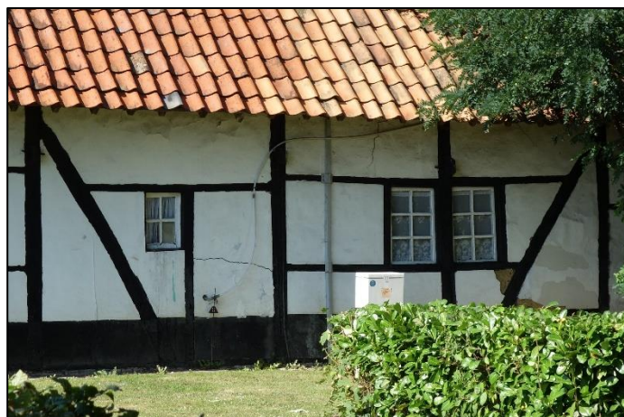
Huidige toestand van dit deel van de zuidgevel.
