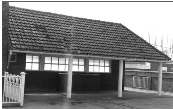
8: Afdak op de plaats waar het oude schoolgebouw aan de Molenstraat stond.
