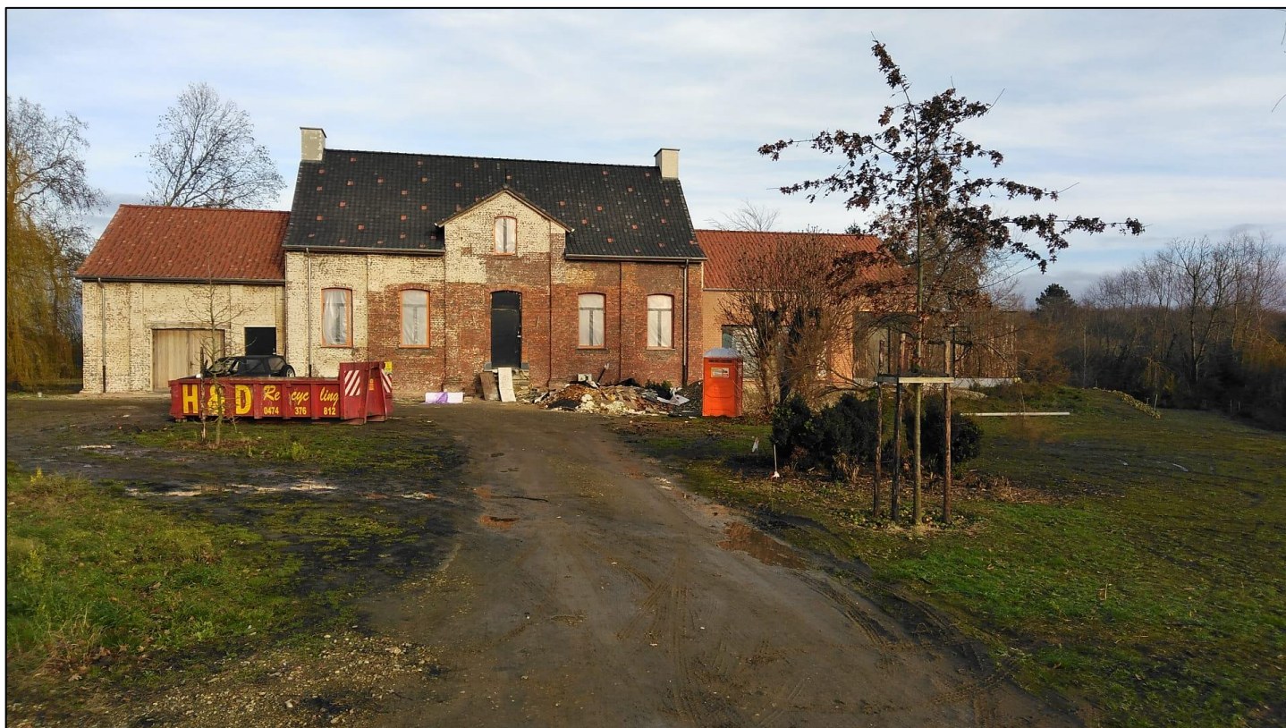
Voorkant van de Schans, nog volop in restauratie, toestand 2020.
